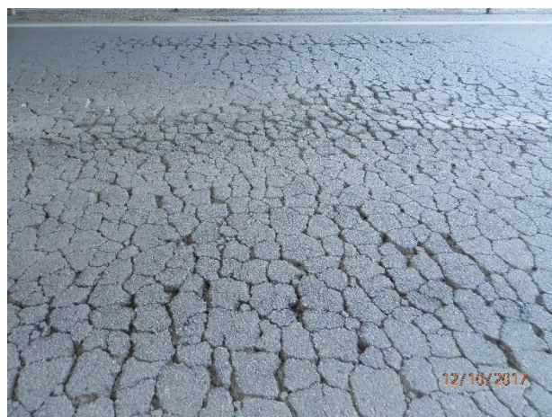
Εικόνα 14: οδόστρωμα κάτω από τη γέφυρα της Εγνατίας
